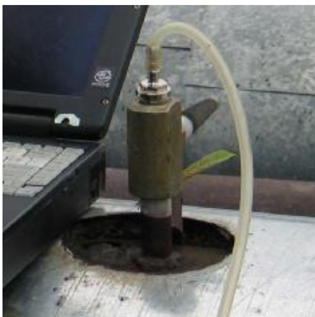
Рис. 5. Пример врезки в трубопровод
